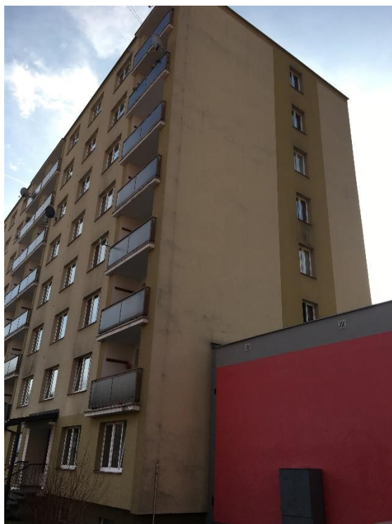
Severní štítová stěna
