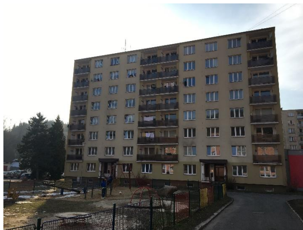
Východní obvodová stěna
