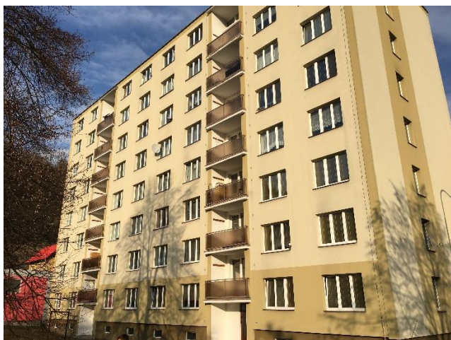
Západní obvodová stěna
