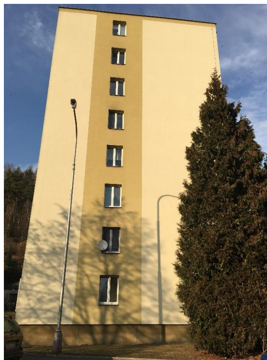
Jižní štítová stěna
